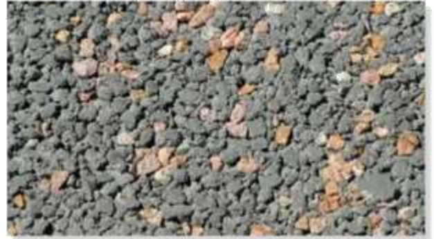
ダイレクト撒石仕上
